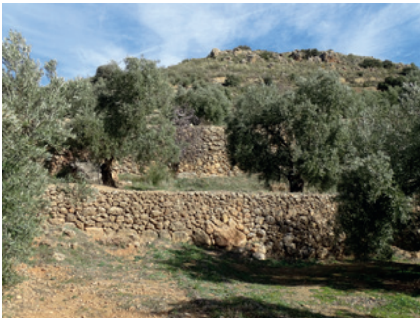
Grandes muros de piedra hechos por “los antiguos”, en los alrededores del cortijo del Salado, nivelan el suelo evitando la erosión del mismo y, al mismo tiempo, lo hacen más fértil
