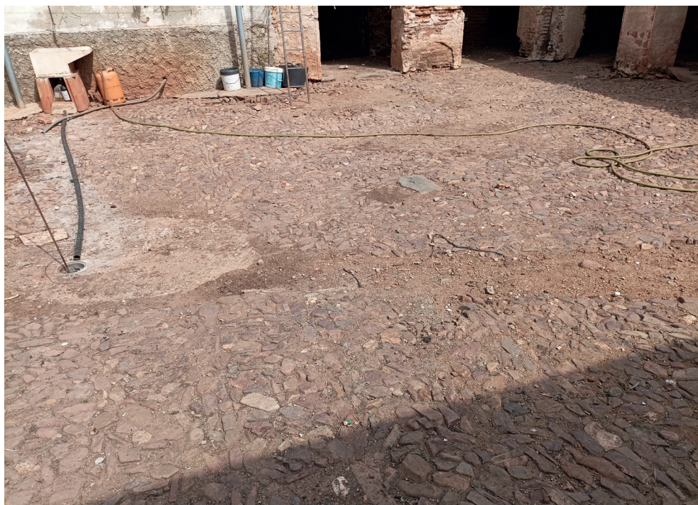
Empedrado del patio del Caserío de Don Bernardo (Navas de San Juan)
