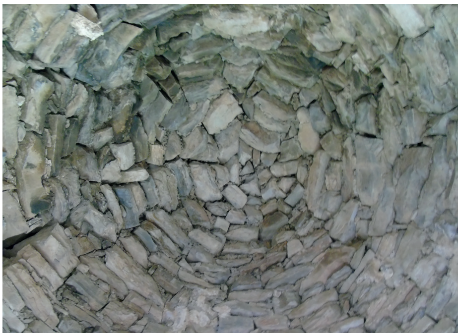
Bóveda del palomar del Cortijo de Calderetes (Navas de San Juan)
